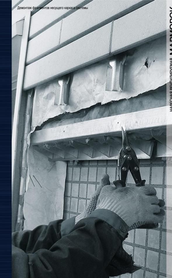
Демонтаж фрагментов несущего каркаса системы
