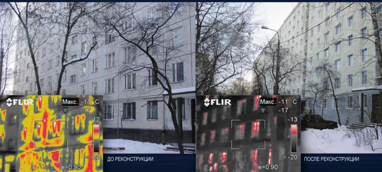
Тепловизионные исследования фасадов зданий перед проведением реконструкционных работ направлены на оценку технического состояния ограждающих конструкций, т.е. обладающие наихудшими теплозащитными характеристиками. Наличие большого количества данных участков говорит о значительных утечках тепла через ограждающие конструкции, и, как следствие, о низких энергосберегающих характеристиках.
